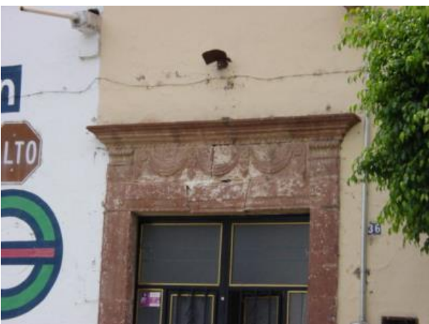
DETALLES ARQUITECTONICOS CARACTERISTICOS EN LA POBLACION.
