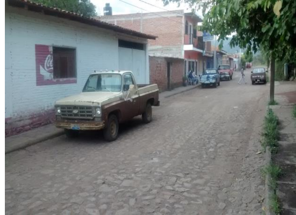
IMAGEN QUE EXPRESA LAS CONDICIONES FISICAS EN REGULAR ESTADO DEL EMPEDRADO EN LA VIALIDAD/VP DONATO GUERRA LA CABECERA MUNICIPAL.
