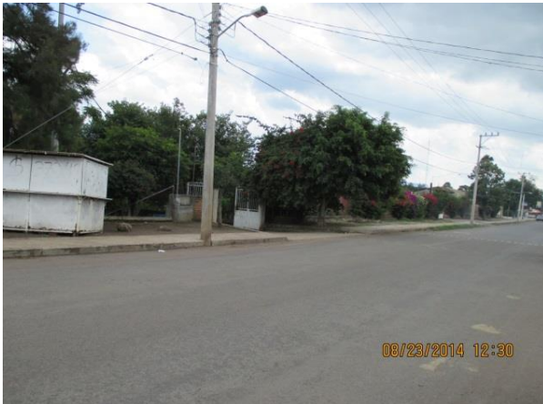
IMAGEN QUE EXPRESA LAS CONDICIONES FISICAS EN BUEN ESTADO DEL ASFALTO EN EL LIBRAMIENTO-TEOCUITATLAN DE CORONA
