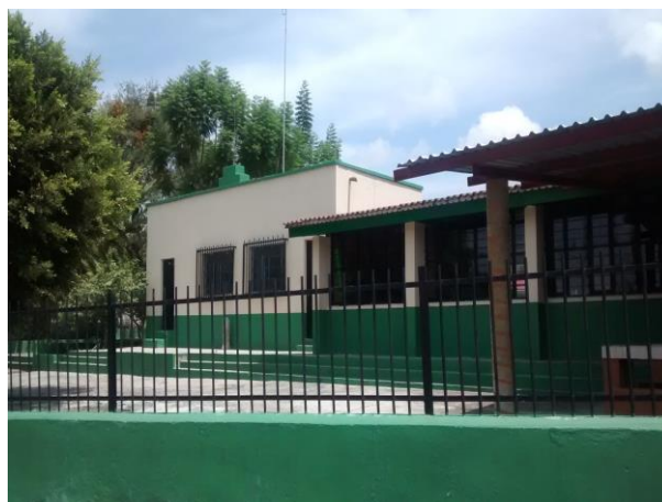
EQUIPAMIENTO INSTITUCIONAL DE NIVEL VECINAL/EI-V CORRESPONDIENTE A EDUCACION/PRIMARIA EN LA LOCALIDAD MILPILLA.
