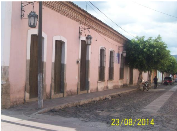
EQUIPAMIENTO INSTITUCIONAL DE NIVEL CENTRAL/EI-C CORRESPONDIENTE A CULTURA/CASA DE LA CULTURA EN LA CABECERA MUNICIPAL.
