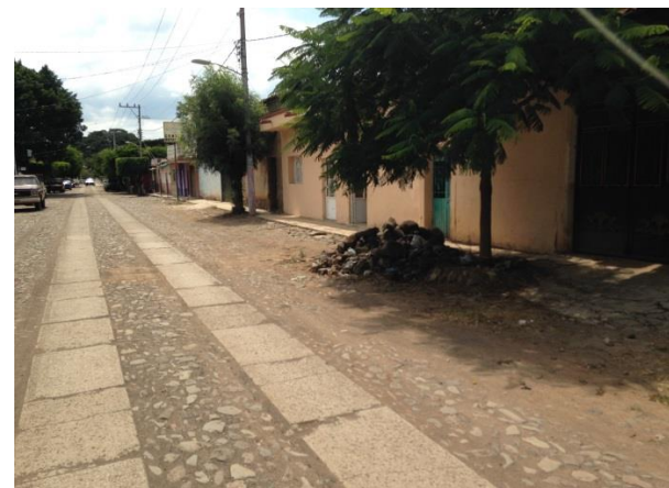
IMAGEN QUE EXPRESA LAS CONDICIONES FISICAS EN REGULAR ESTADO DEL EMPEDRADO EN LA VIALIDAD/VP DONATO GUERRA EN LA LOCALIDAD DE CITALA.
