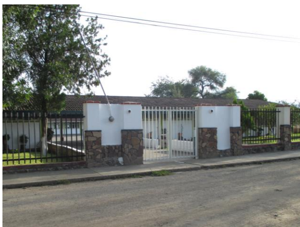
VISTA DEL EQUIPAMIENTO INSTITUCIONAL DE NIVEL VECINAL/EI-V CORRESPONDIENTE A LA PRIMARIA EN LA LOCALIDAD DE SAN JOSE DE GRACIA.
